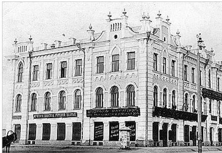
Объект культурного наследия «Купеческий клуб» (г. Красноярск, пр. Мира, 71)
